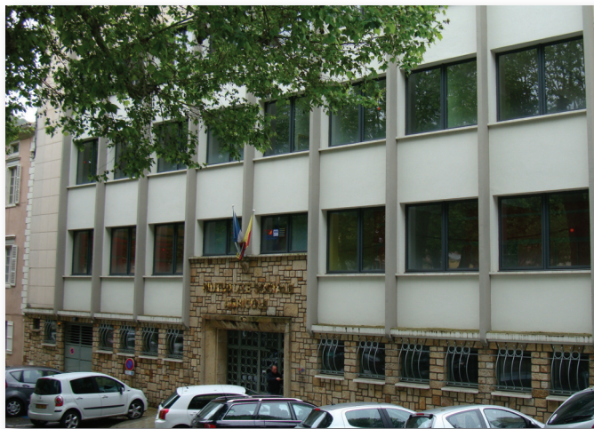
Façade rénovée de la caisse ariégeoise
